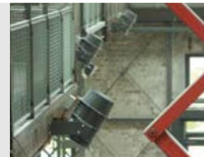
**Безопасное дымоудаление и естественный отвод тепла из галерей и атриумов.** Импульсные струйные вентиляторы серии X-FANS являются первыми вентиляторами, которые поддерживают естественный отвод тепла и дыма. При высоких температурах тепло накапливается под крышей. Импульсный струйный вентилятор способствует рассеиванию тепловых нагрузок через отверстия в крыше. В случае пожара импульсная струя вентилятора позволяет поддерживать выбранные пути эвакуации практически полностью свободными от дыма.
