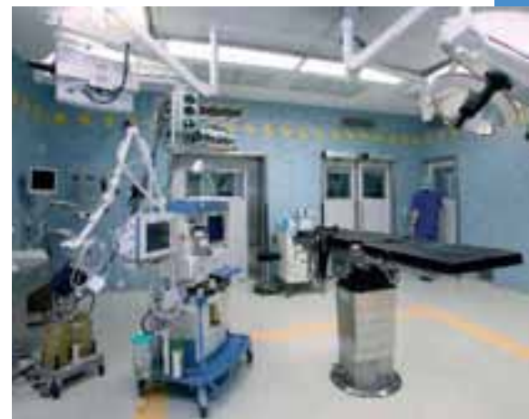
Муниципальный центр здравоохранения, Дюссельдорф (Германия)
