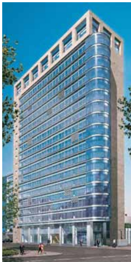
Здание Lighttower, Франкфурт на Майне (Германия)
