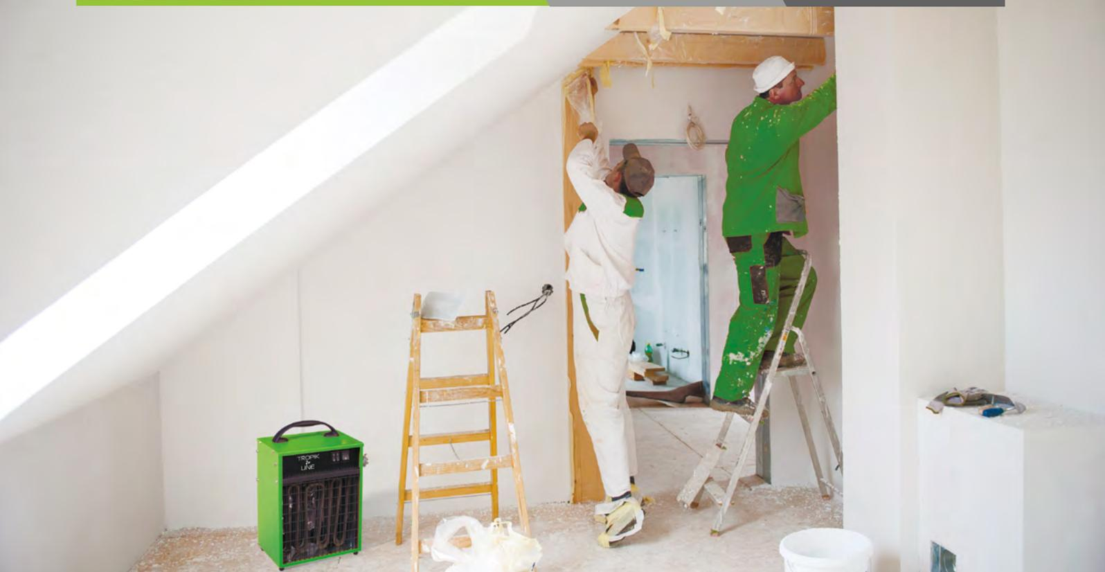
Тепловые пушки – это отопительный прибор, обогревающий помещение за счет нагревания воздушного потока, который создается при помощи встроенного вентилятора.
