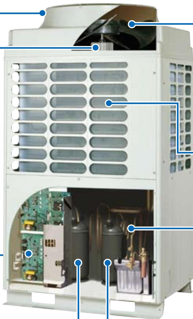
**Осевой вентилятор новой конструкции с большим рабочим колесом**
