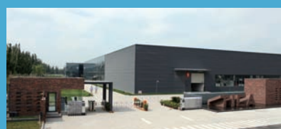
Производственная база в Тяньцзине
