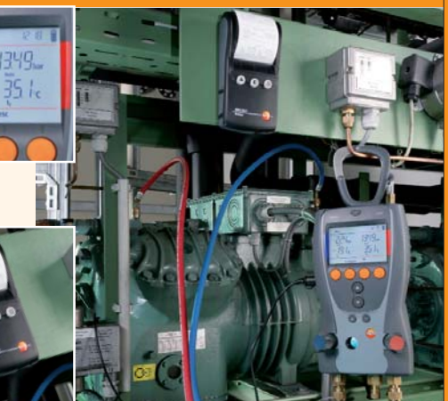
Замена хладагента в холодильной системе с использованием testo 523
