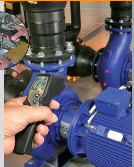
Проверки, напр., температуры компрессора
