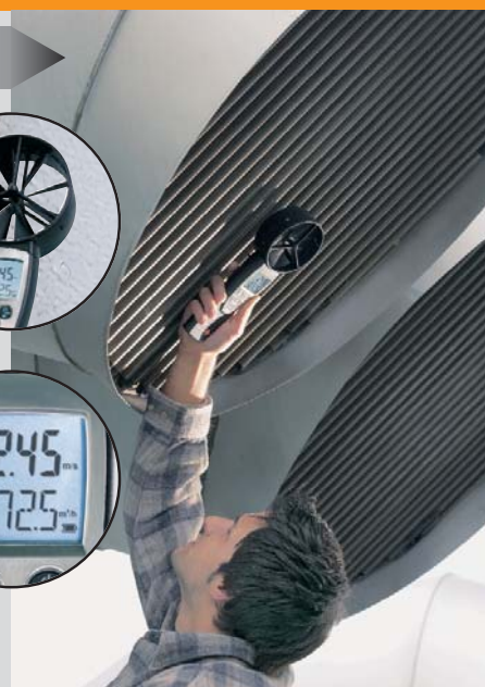
Измерения объемного расхода с помощью крыльчатки диаметром 100 мм на выходах воздуховодов
