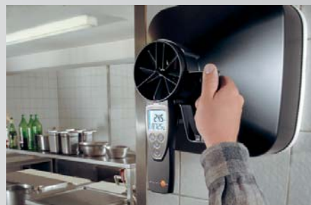
Мониторинг отработанного воздуха в настенных вентиляторах
