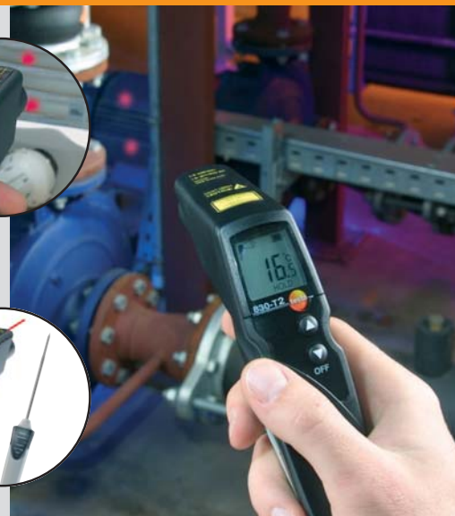
Контрольные замеры, например, температуры компрессора
