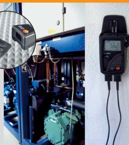
Измерение температуры воздуха до и после конденсатора в холодильных агрегатах
