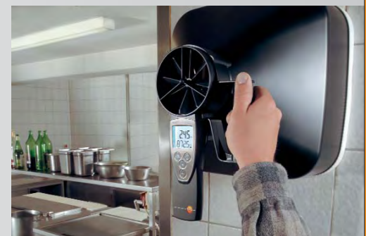
Мониторинг отработанного воздуха в настенных вентиляторах
