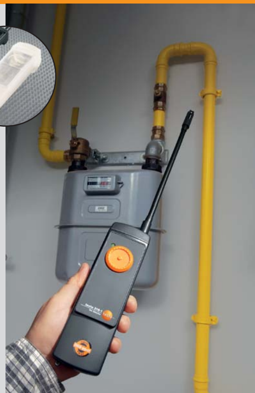
Проверка возможных утечек в трубопроводах
