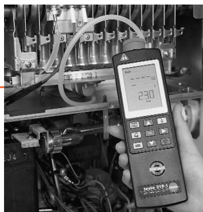
Испытание на герметичность с использованием прибора testo 312-1/2
