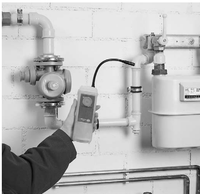
Рис. 26: Обнаружение утечки газа в трубах с помощью прибора testo 316-1
