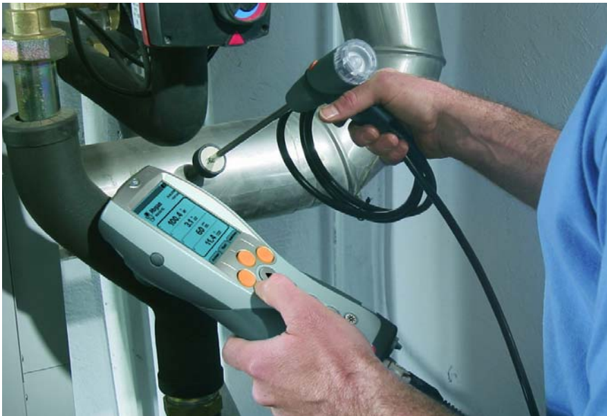
Рис. 13: Определение потери тепла с дымовыми газами
