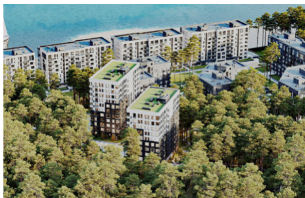
ЖК «Флора и Фауна» г. Новосибирск, 2018-2019 г.г.
