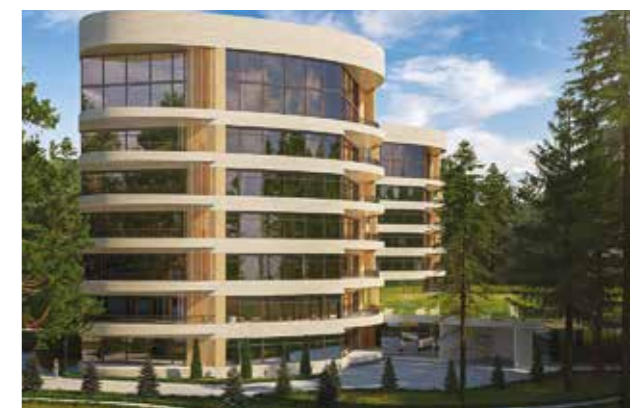
ЖК «Флора и Фауна» г. Новосибирск, 2018-2019 г.г.
