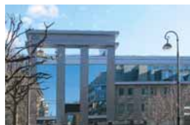
Административное здание, ул. Чапыгина, г. Санкт-Петербург
