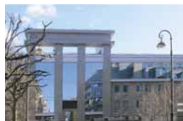
Административное здание, ул. Чапыгина, г. Санкт-Петербург
