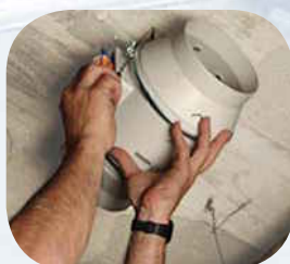
Установите корпус вентилятора
