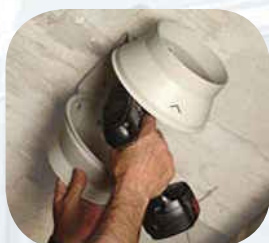
Закрепите основание вентилятора
