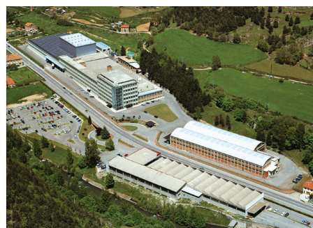
● Производственный комплекс в Риполе (Испания)
