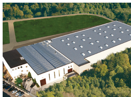
● Завод в Силс (Испания)
