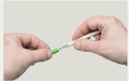
Удалите оплетку и снимите витой экран
