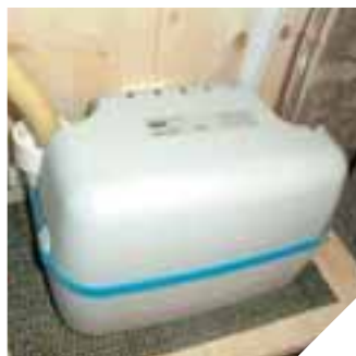
Sanicondens, соединенный с осушителем
