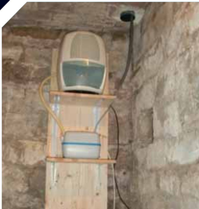
Установленный в подвале осушитель
