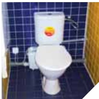
Установка Sanibest на один унитаз для взрослого
