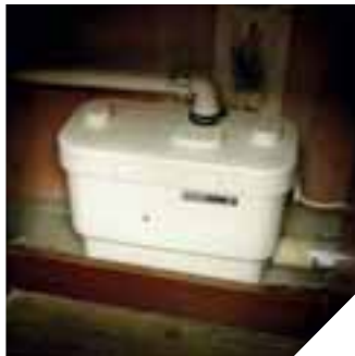
Sanispeed, вмонтированный в шкаф раковины
