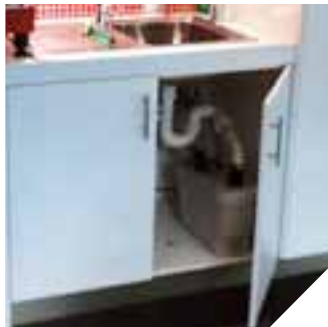
Sanispeed, вмонтированный в шкаф раковины
