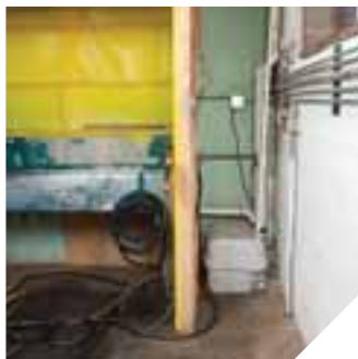
Монтаж насоса Sanicubic
