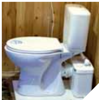
Унитаз, установленный в бане, с насосом Sanibroyeur
