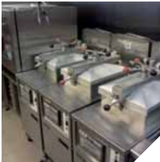
Кухонные плиты, стоящие на отдалении от канализационной трубы
