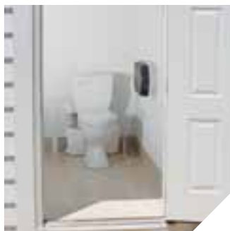
Туалет, оборудованный системой измельчения Saniplus
