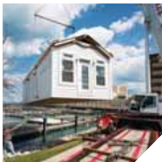
Кран устанавливает гигиеническое сооружение на воду
