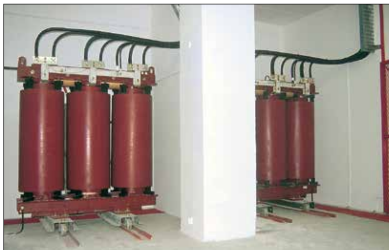
Стандартные присоединения ВН и НН сверху
