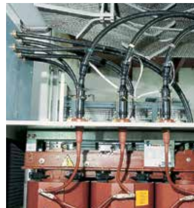
Присоединения ВН сверху через разъемы (1) (на заказ)
