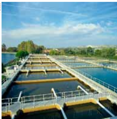
Установка для очистки сточных вод
