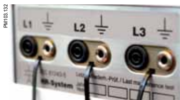
Гнезда для индикаторов неинтегрированной системы контроля напряжения трёх фаз
