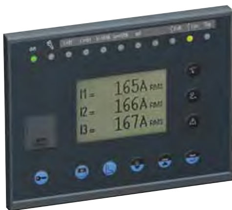
Выносной модуль усовершенствованного UMI DSM303
