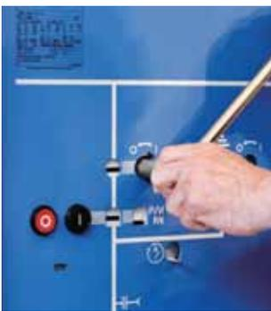
Механическое обслуживание разъединителя
