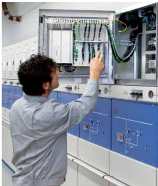
В низковольтный шкаф встраиваются вторичные устройства и реле защиты для управления, измерения, учета и другие системы. Низковольтный шкаф, отделенный от первичной части, является безопасным для прикосновения и стойким к воздействию аварийной дуги и представляет собой самостоятельный закрытый низковольтный отсек, имеющий механический и электрический интерфейс с каркасом ячейки. Особенным преимуществом для пользователя является возможность демонтажа низковольтного шкафа.
