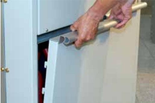
Открытие нижней крышки отсека кабельных присоединений после отпирания
