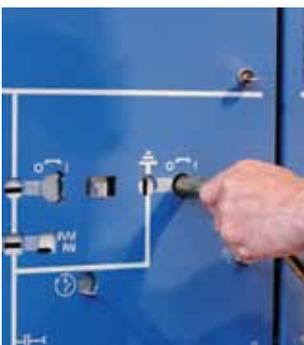
Механическое обслуживание заземлителя
