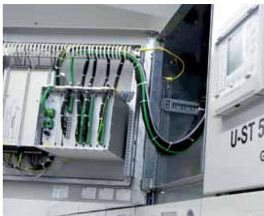
Низковольтный шкаф с встроенными в дверь приборами
