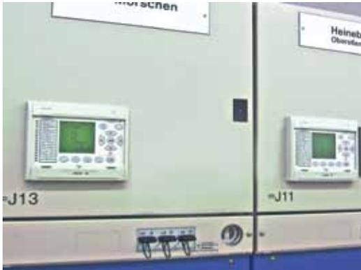
Блок управления ячейкой MICOM в РУ GMA
