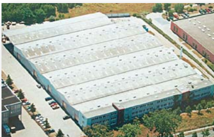
Завод по производству труб из нержавеющей стали NiroSan®, г. Берлин, Германия
