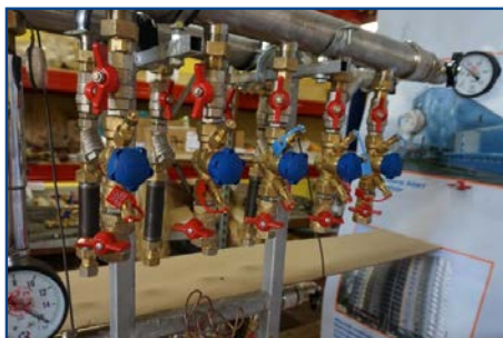
Гидравлические испытания РКУ SANEXT
