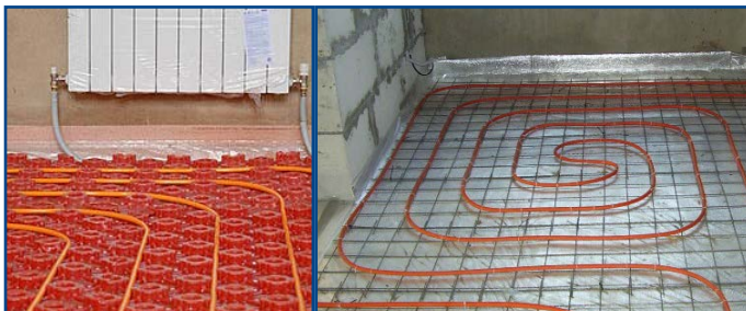
Примеры укладки трубы SANEXT «Тёплый пол»
