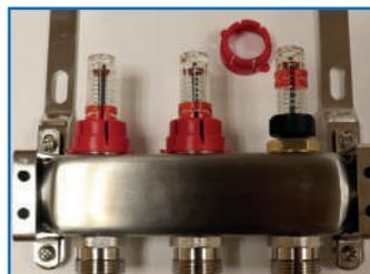
Для регулирования расхода необходимо на обратном коллекторе снять белый колпачок, установить сервопривод (приобретается отдельно). Для полного перекрытия потока теплоносителя через отдельный контур необходимо: на подающем коллекторе установить значение настройки на настроечном клапане расходомером в положение «0». На обратном коллекторе: закрутить белый колпачок до упора.
