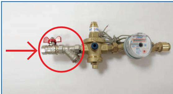
**7.2.1 СП 30.13330.2016:** ...перед счетчиками (по ходу движения воды) следует предусматривать установку механических или магнитно-механических фильтров. Потери давления в фильтре не должны превышать 50 % потерь давления, указанных в 7.2.11.
