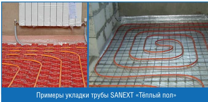
**6.3.5 СП 60.13330.2016:** При напольном отоплении полимерные трубы следует прокладывать без гофротрубы.
