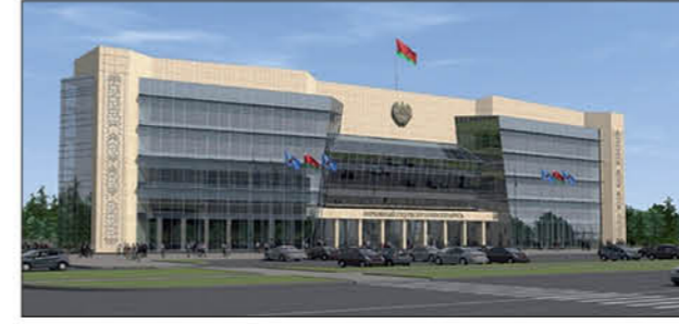
Республика Беларусь Здание Верховного суда Наружные блоки: серия DVM S, 17 шт. Внутренние блоки: 271 шт. (настенные, кассетные) Суммарная производительность: 712 кВт
