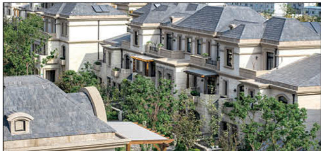
Китай, Шанхай ЖК HONGQIAO INTERNATIONAL GARDEN, Хунцяо Наружные блоки: серия DVM S, 663 шт. Внутренние блоки: 5052 шт. (кассетные, канальные) Суммарная производительность: 20,2 МВт
