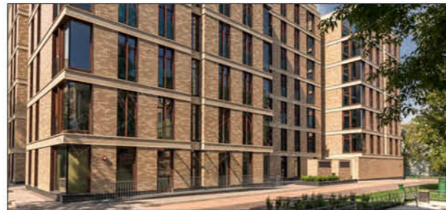
Российская Федерация, Москва «Гороховский 12» Наружные блоки: серия DVM S, 14 шт. Внутренние блоки: 86 шт. Суммарная производительность: 462 кВт
