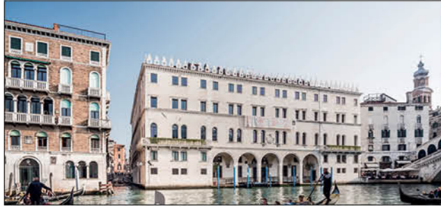
Италия, Венеция Фондако-деи-Тедески (Fondaco Dei Tedeschi) Старейшее здание в Венеции Наружные блоки: серия DVM S, 12 шт. Внутренние блоки: 79 шт. (канальные, настенные) Суммарная производительность: 640 кВт
