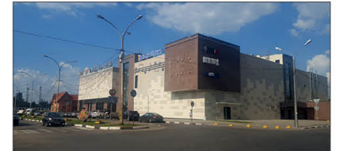
Российская Федерация, Моск. обл. «Мелодия» Наружные блоки: серия DVM S, 13 шт. Внутренние блоки: 84 шт. (кассетные, канальные) Суммарная производительность: 540 кВт
