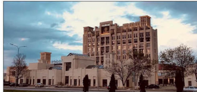
Российская Федерация, Грозный Отель The Local Наружные блоки: серия DVM S, 37 шт. Внутренние блоки: 274 шт. (канальные, кассетные) Суммарная производительность: 1,5 МВт
