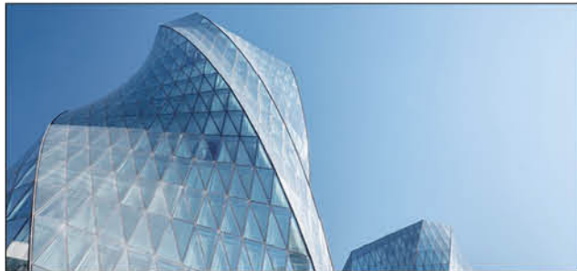
Турция, Стамбул Бургу Арджаан (Burgu Arjaan) Наружные блоки: серия DVM S Water, 96 шт. Внутренние блоки: 306 шт. (канальные) Суммарная производительность: 2,3 МВт
