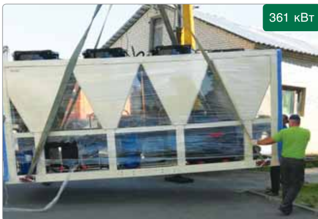
НВП «АСТРАФАРМ», БАЛАШИХА чиллер воздушного охлаждения
