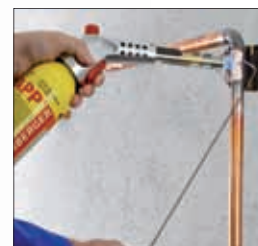
Пайка мягким припоем при монтаже системы отопления
