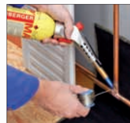
Пайка при монтаже системы подачи газа
