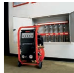
Промывка системы отопления пола
