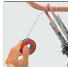
Нагрев места пайки без использования пламени
