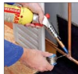
Пайка при монтаже системы подачи газа
