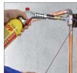
Пайка мягким припоем при монтаже системы отопления
