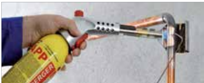
Пайка твёрдым припоем при монтаже системы газоснабжения
