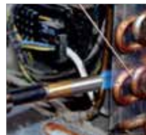
Пайка твёрдым припоем систем кондиционирования и холодильных систем
