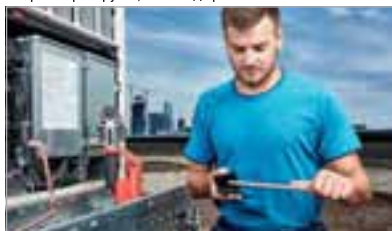
5. Проконтролируйте, есть ли дефекты
