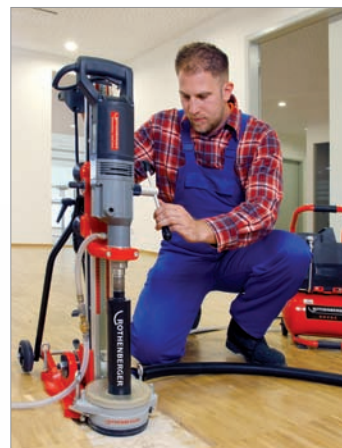
Чистая работа в закрытых помещениях.
