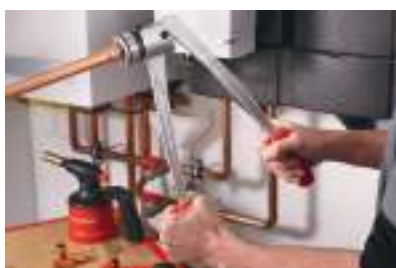
Рациональный бесфитинговый монтаж трубопровода
