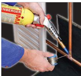
Пайка мягким припоем при монтаже системы отопления
