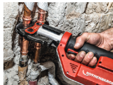
Тwin Turbo при выполнении ремонтных работ
