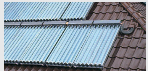
Установка на крыше
