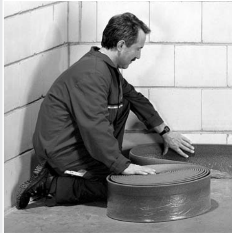
Verlegung des Roth-Randdämmstreifens
