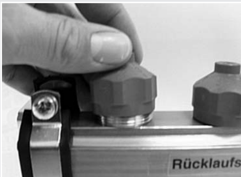
Die Bauschutzkappe des sich im Rücklauf befindlichen Thermostatventils ist abzuschrauben.
