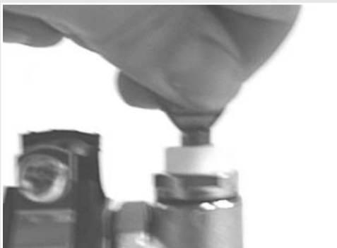
Die Entlüftung des Heizkreises erfolgt über die seitlich angebrachten Füll- und Entleerungsstopfen mit manueller Entlüftung. Die Entlüftungskappe ist mit einem Entlüftungsschlüssel leicht zu öffnen, bis die gesamte Luft entwichen ist. Anschließend ist diese Entlüftungskappe wieder zu verschließen.
