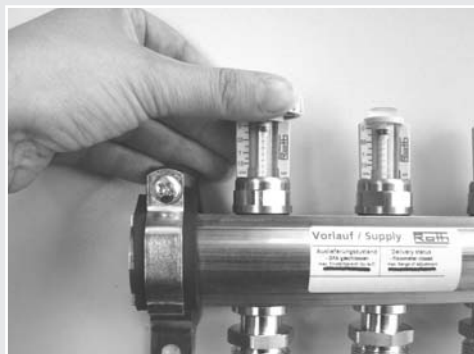
Die geforderte Durchflussmenge des Heizkreises wird mit dem beigelegten Handrad eingestellt.
