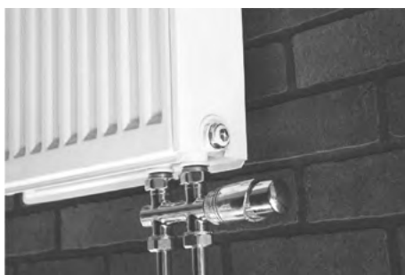
Непосредственное подключение трубы к радиатору с помощью H-образной гарнитуры и медных L- и T-образных трубок
