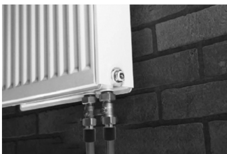
Непосредственное подключение трубы к радиатору через H-образную гарнитуру
