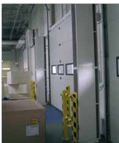
Windbox Две вертикальные завесы для дверей промышленных зданий
