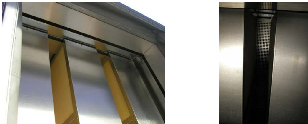
Рис. 3.31. Пластинчатые шумоглушители
