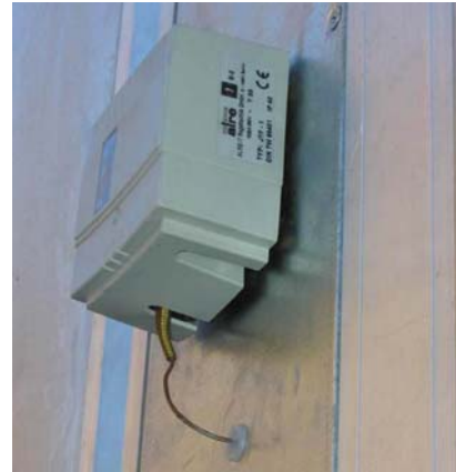
Рис. 4.21. Установка воздушного термостата
