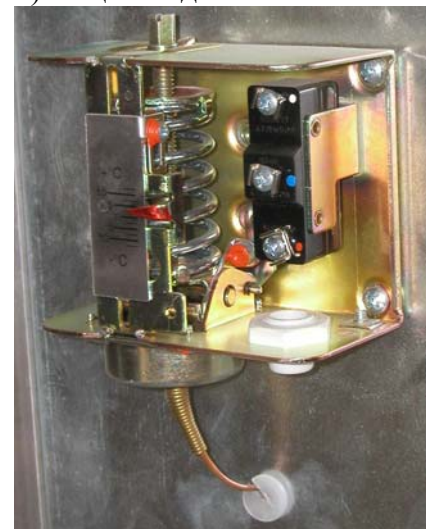
Рис. 4.22. Клеммный зажим воздушного термостата от замораживания
