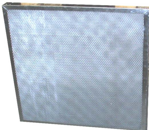
Рис. 3.21. Металлотканевый ячейковый фильтр
