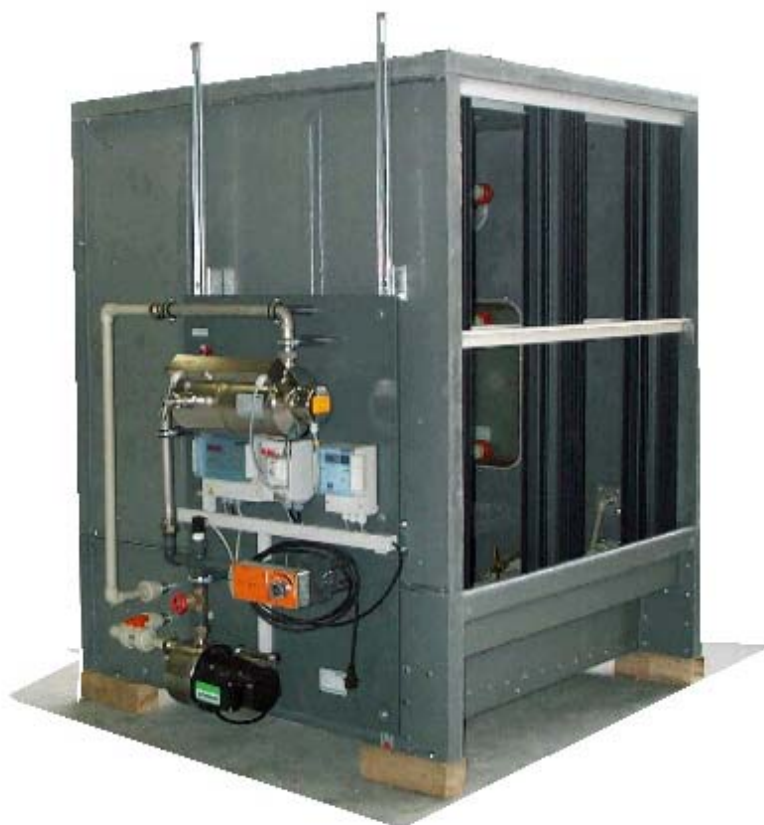
Рис. 3. 28. Общий вид камеры орошения
