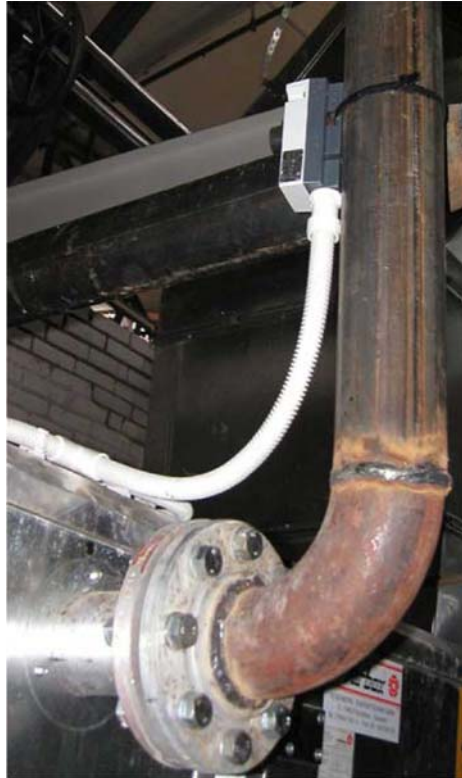
Рис. 4.27. Установка накладного термостата на трубопровод
