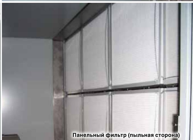
Фильтр тонкой очистки (HEPA)
