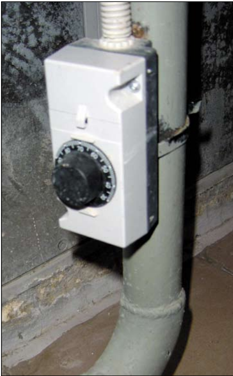
Рис. 4.27. Установка накладного термостата на трубопровод
