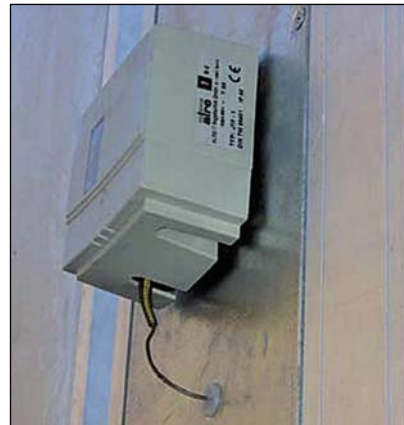
Рис. 4.21. Установка воздушного термостата
