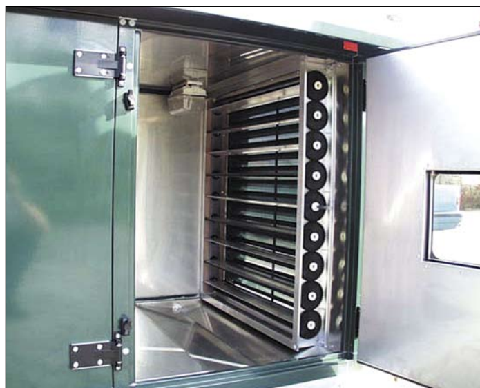
в) расположение клапана внутри установки
