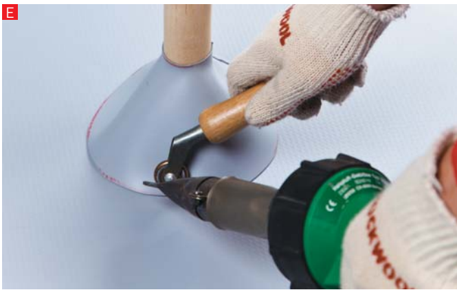
Г. Разогреваются внутренняя и внешняя кромки конуса.
