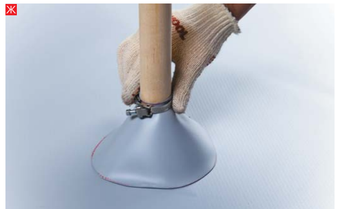
Д. И пока не остыла мембрана натягиваются на изолируемый проход.
