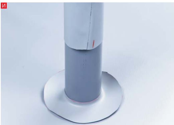
И. После этого подготовленная трубка из мембраны натягивается на изолируемую трубу.
