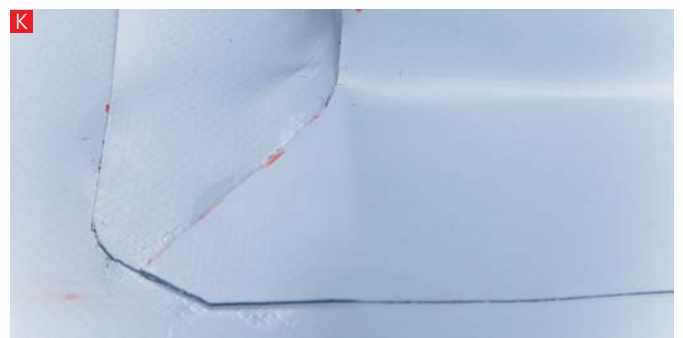
К. Полностью изолированный внешний угол плоской кровли.
