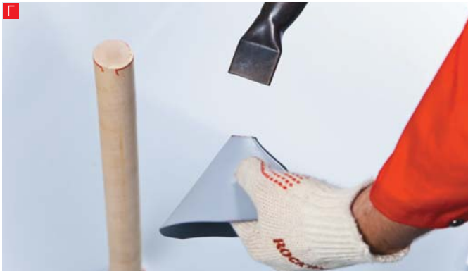
Г. Разогреваются внутренняя и внешняя кромки конуса.
