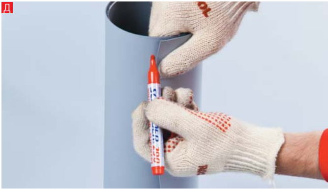
Д. Эта полоска мембраны примеряется на трубе, отмечается рисками положение свернутой на трубе мембраны.
