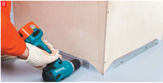
В. Механически закрепляется с помощью специальных шин, изображенных на фото в п. 7.
