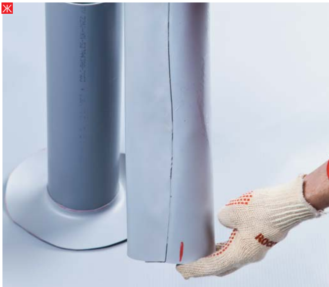
Ж. Торец мембраны, сваренной трубкой, разогревается горячим воздухом.
