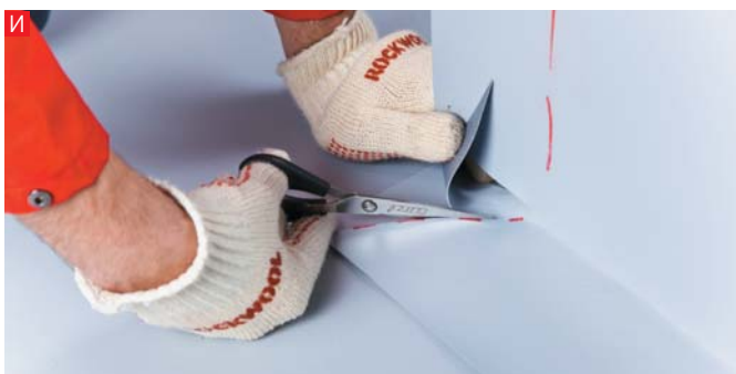
И. Наконец, провариваются горизонтальные поверхности.
