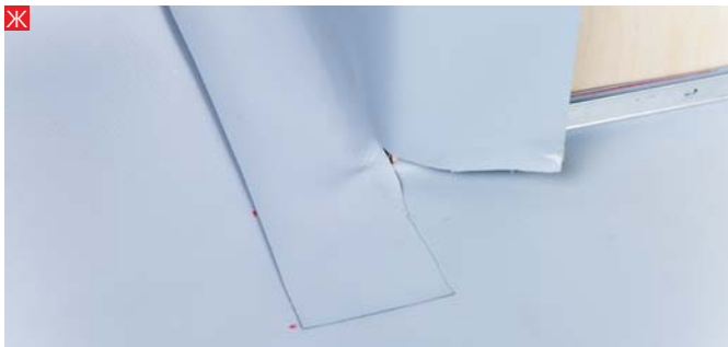
Ж. Затем провариваются вертикальные соединения мембран.
