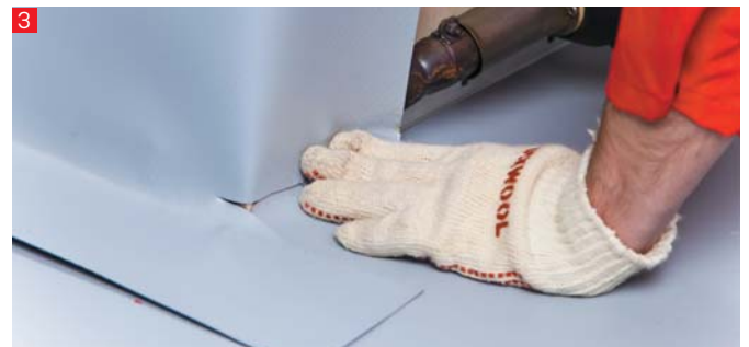
З. Аналогично производится укладка мембраны на других вертикальных поверхностях.
