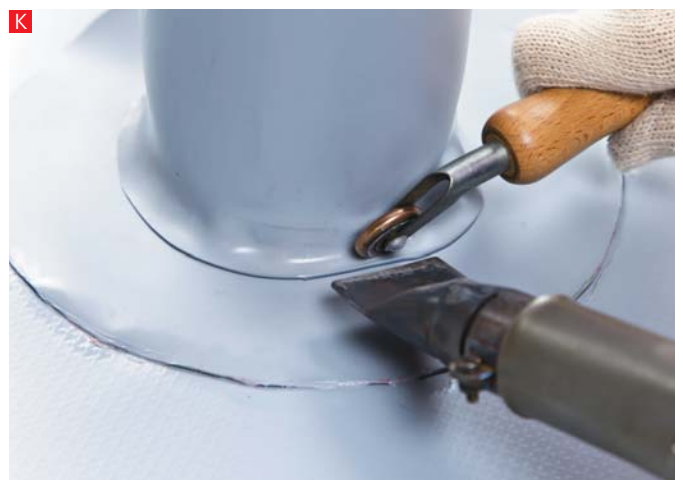
К. И приваривается внизу к горизонтальному кольцу с использованием узкого металлического ролика.
