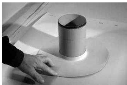
Рисунок 3.4. После этого кольцо по всей поверхности приваривают к кровельной мембране. Для изоляции вертикальной поверхности трубы вырезают полосу из неармированной мембраны шириной, равной высоте изолируемой поверхности, но не менее 150 мм, и длиной на 50 мм больше длины окружности трубы.
