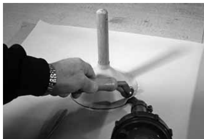
Рисунок 4.6. Нижнюю кромку конуса приваривают к кровельной мембране.
