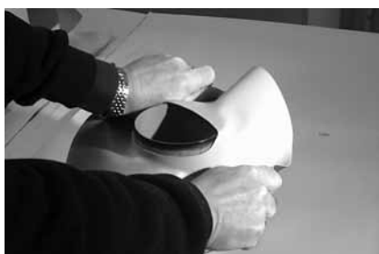
Рисунок 3.3. И быстро, пока не остыла мембрана, натягивают на трубу до горизонтальной поверхности кровли.
