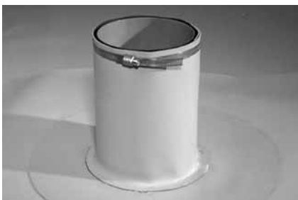
Рисунок 3.11. Верхнюю часть трубки обжимают металлическим хомутом и заливают герметиком.
