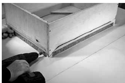
Рисунок 1.3. Механически закрепляют с помощью специальных шин.
