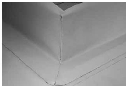
Рисунок 1.10. Полностью изолированный внешний угол вентиляционной шахты.
