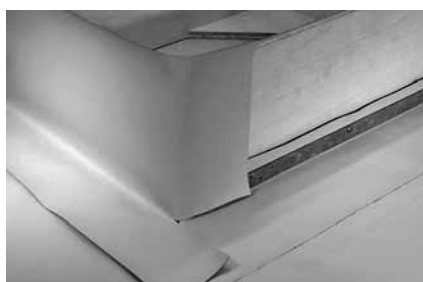
Рисунок 1.7. Затем проваривают вертикальные соединения мембран.
