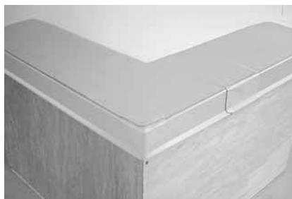
Рисунок 5.4. Сверху на профили из ламинированной ПВХ-жести наваривают мембрану ROCKmembrane.
