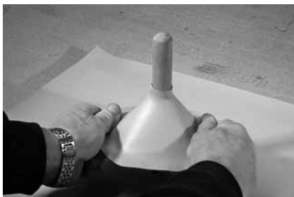
Рисунок 4.5. И пока не остыла мембрана, натягивают на изолируемый элемент.
