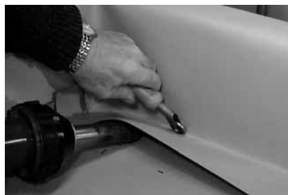
Рисунок 1.6. И проваривают ручным феном сначала в месте сгиба.
