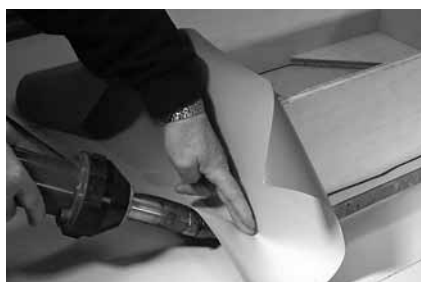
Рисунок 1.5. С вертикальной поверхности до этих отметок спускают мембрану.
