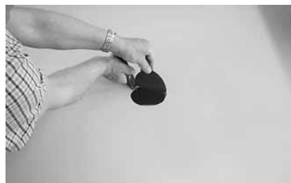
Рисунок 6.2. В кровельной мембране над водоприемной трубой вырезают отверстие немного больше диаметра трубы.
