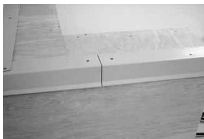
Рисунок 5.2. Следующий сформированный профиль из ламинированной ПВХ-жести крепят на внешней стороне парапета со стороны фасада с интервалом от уже закрепленного. Интервал выбирают равный 2 мм на каждый погонный метр ПВХ-жести.
