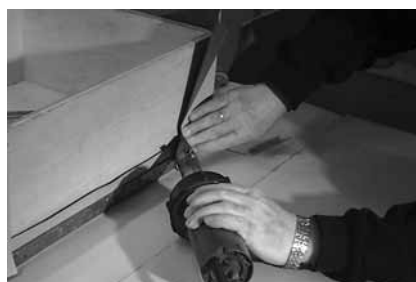
Рисунок 1.8. Аналогично производится укладка мембраны на других вертикальных поверхностях.
