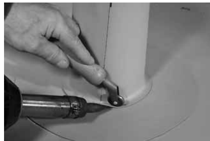
Рисунок 3.10. И приваривают внизу к горизонтальному кольцу, с использованием узкого металлического ролика.
