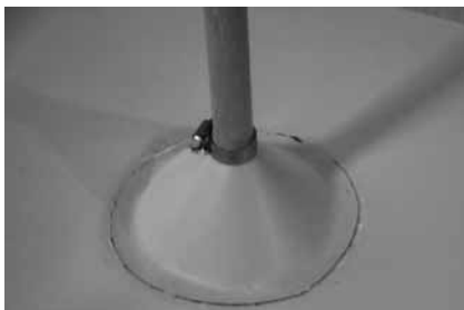
Рисунок 4.7. А верхнюю часть конуса зажимают металлическим хомутом и заливают герметиком.
