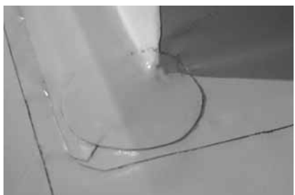
Рисунок 1.11. Для надежности герметизации угловой точки «внешнего угла» на поверхности кровли устанавливают накладку внешнего угла.
