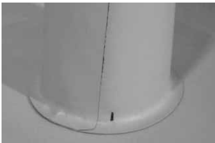
Рисунок 3.9. После этого подготовленную трубку из мембраны натягивают на изолируемую трубу.
