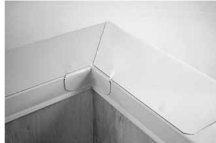
Рисунок 5.6. Внутренний угол профиля из ламинированной ПВХ-жести на парапете со стороны кровли заваривают полосой из неармированной ПВХ-мембраны ROCKmembrane шириной около 20 см.
