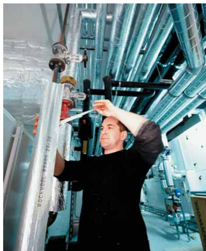
Теплоизоляция трубопроводов инженерных систем Цилиндрами, кашированными алюминиевой фольгой
