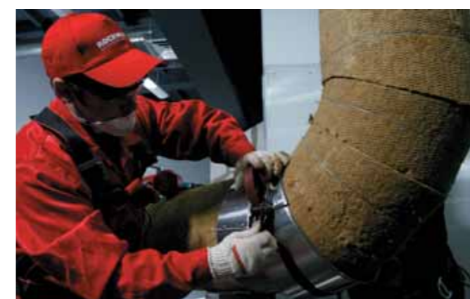
Теплоизоляция отвода трубопровода Цилиндрами
