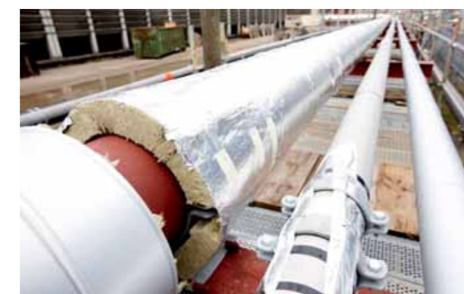
Теплоизоляция промышленного трубопровода Цилиндрами
