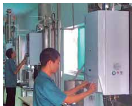
► Работа по выборочному тестированию котлов
