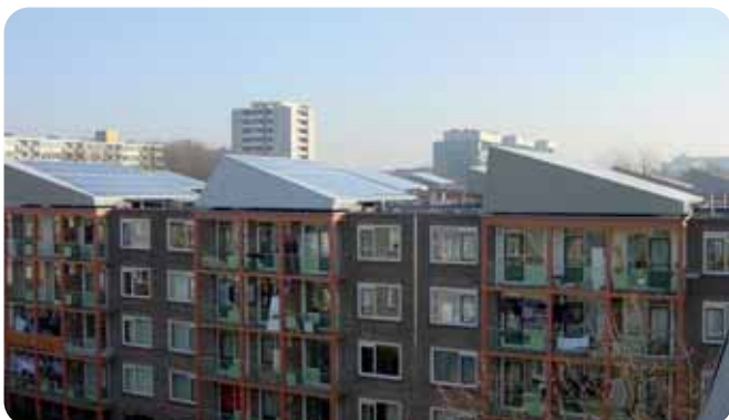
Жилой дом 2 Megawatt Project, Голландия
