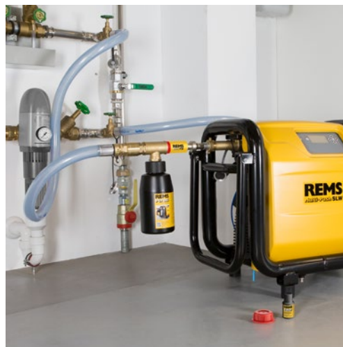
Дезинфекция сантехнического оборудования питьевого водоснабжения
