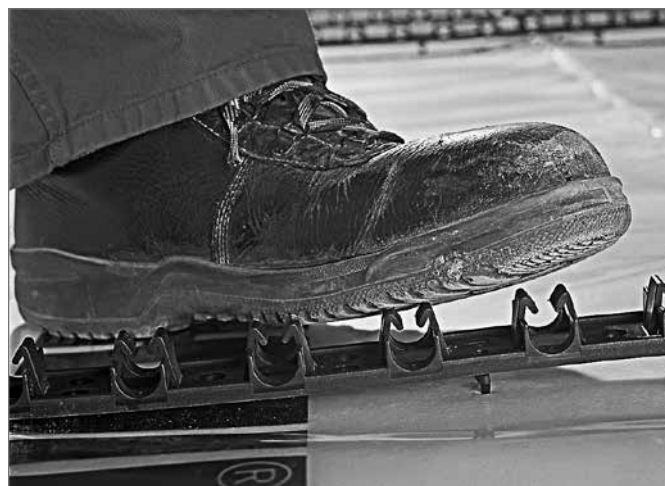
Рис. 21-46 Вдавливание фиксирующих шин RAUFIX в конструкцию пола
