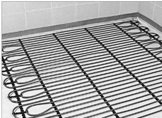
Рис. 21-67 Напольная фиксирующая шина для «мокрого» способа монтажа
