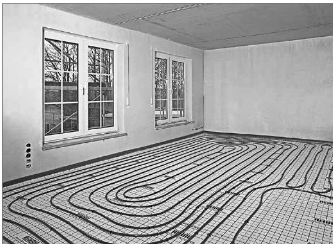
Рис. 21-33 Система крепления труб с помощью гарпун-скоб
